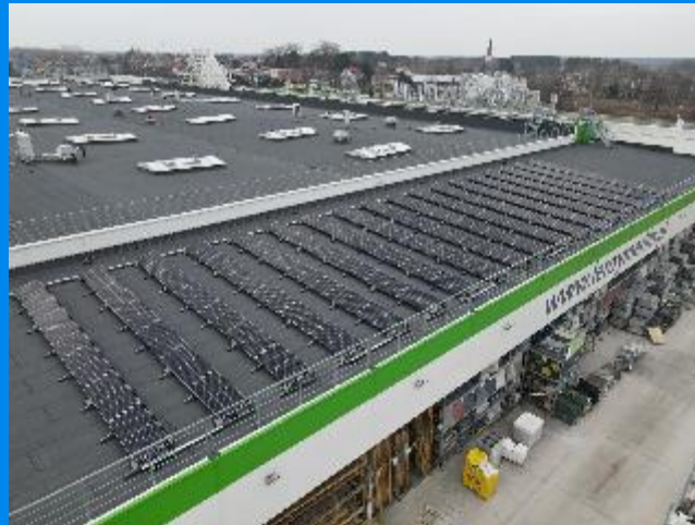
Leroy Merlin 12 instalacji po 50 kWp
