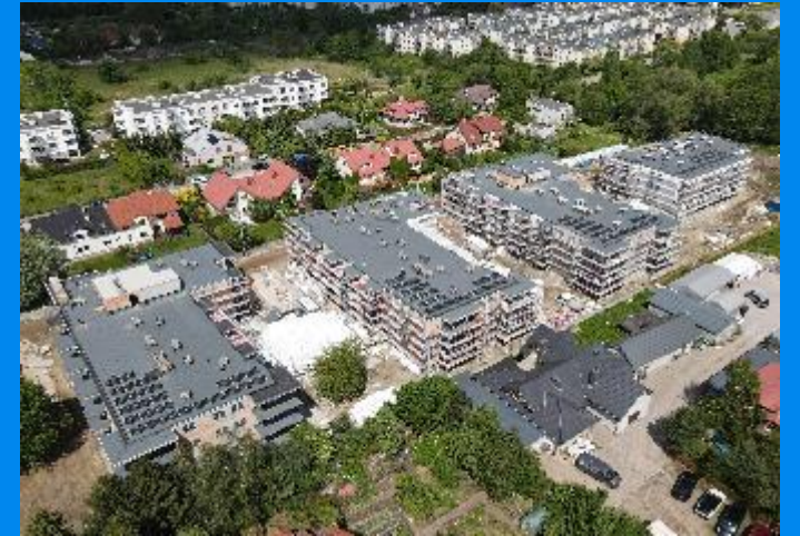
Osiedle Ostródzka w Warszawie 6 instalacji po 10 kWp
