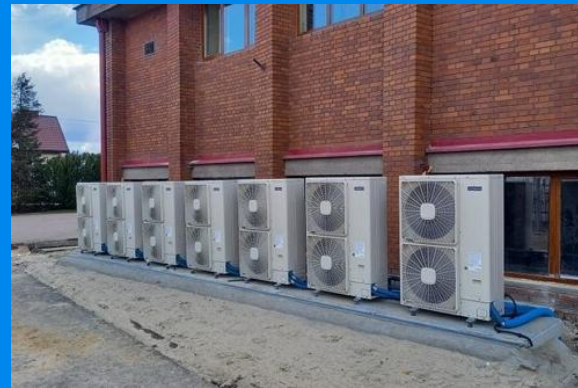
Hitachi Yutaki S - kaskada Domowa instalacja
