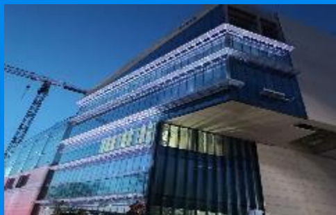
ZUSOK Spalarnia odpadów w Warszawie
